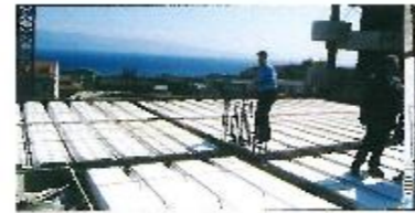
شکل ۳- پانل‌های سقفی هنگام میلگردگذاری
